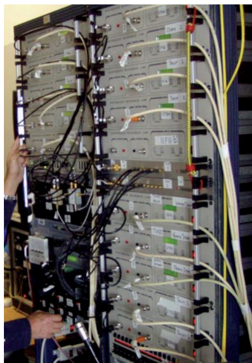
I ricevitori COFDM installati presso la TVNZ
